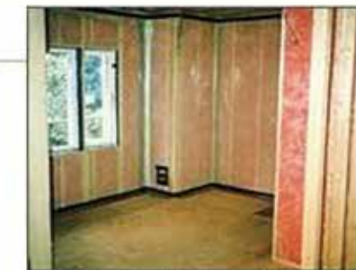
ダンタイト®施工の様子
